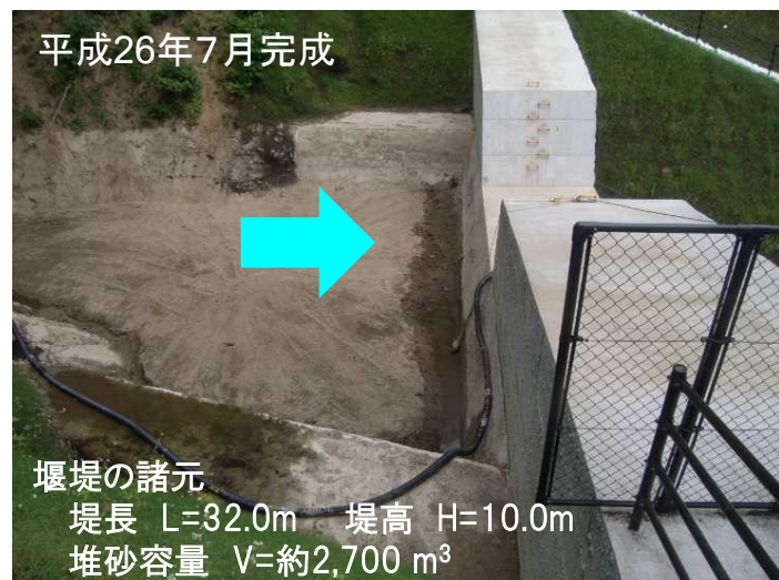
土石流発生前 (H26.9.17撮影)
