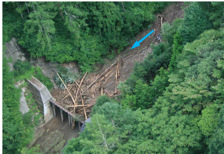
土石流発生後（R3.8.20撮影）
