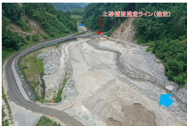
土砂捕捉前 (R3.6.30撮影)
