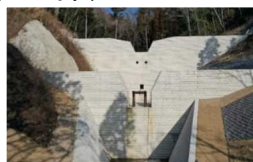
砂防堰堤の整備
