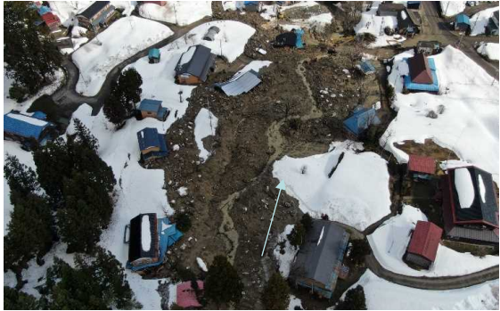
被害状況写真
