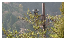
警戒避難体制の強化 （土石流監視カメラの設置）
