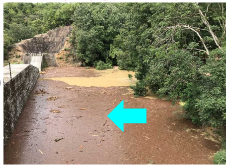
土石流発生直後（R3.8.15撮影）
