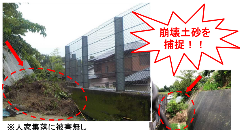
土砂捕捉状況
