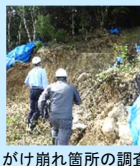
がけ崩れ箇所の調査
