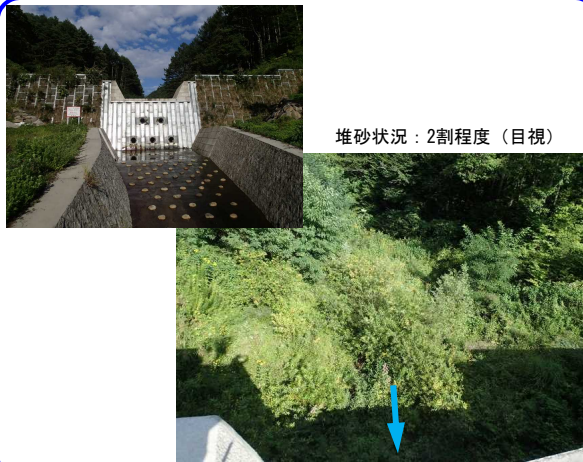
土石流発生前 (H25.8.28撮影)
