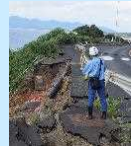
地すべり箇所の調査
