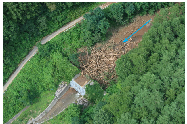
土石流発生後 (R3.8.20撮影)
