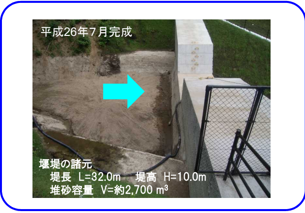
土石流発生前 (H26.9.17撮影)
