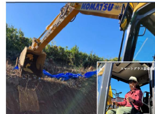
スマートグラスを活用し施工の 効率化と安全性を向上
