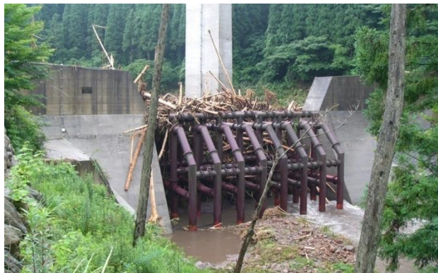
透過型砂防堰堤(熊本県小国町)
