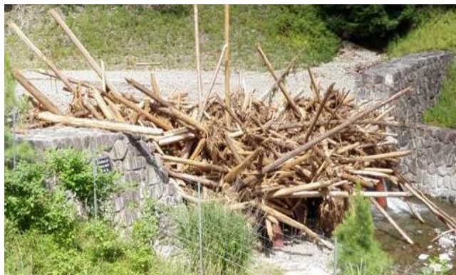
流木捕捉工(兵庫県宍粟市)
