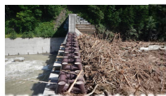
砂防事業による流木捕捉
