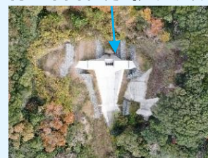
▲ 青山第四堰堤 (アングル2)
