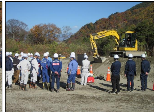
【ICT法面整形工を見学する参加者】
