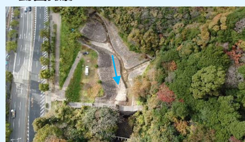
▲ 青山堰堤 (下流側から)
