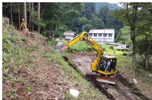
MC掘削状況
