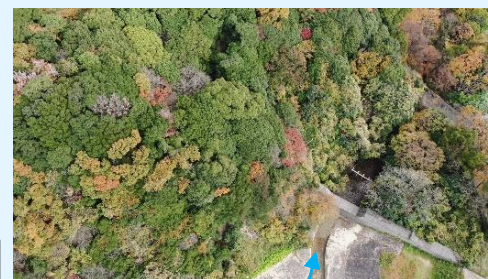
▲ 青山堰堤 (上流側から)
