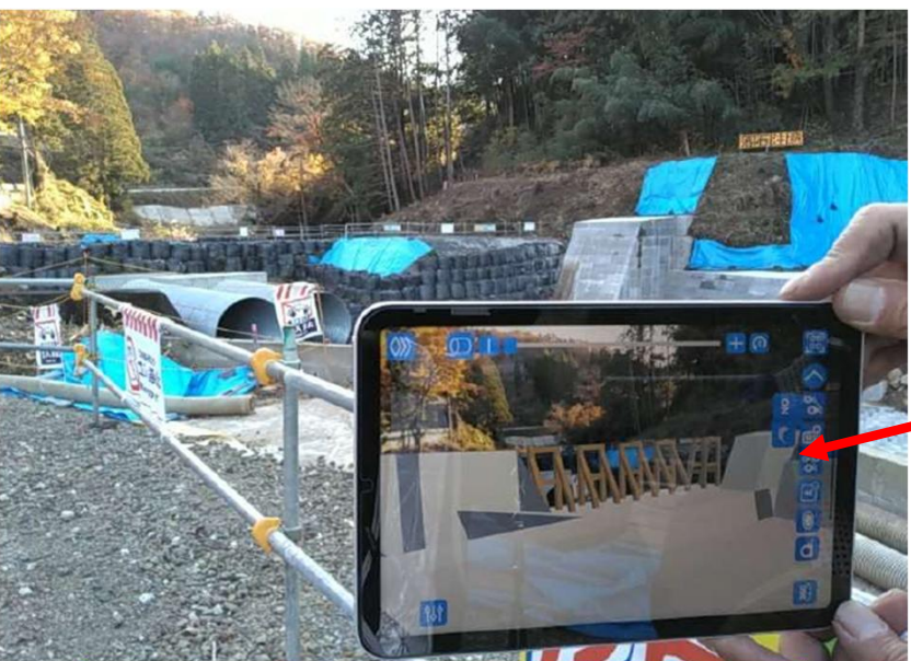
AR技術により3次元データで現場確認が可能
