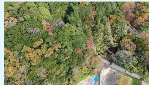
▲ 青山堰堤 (上流側から)
