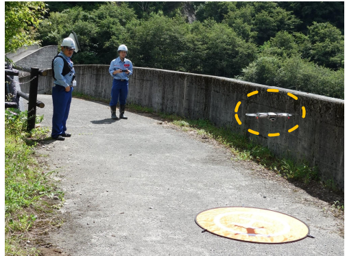
UAVを用いた現地調査状況
