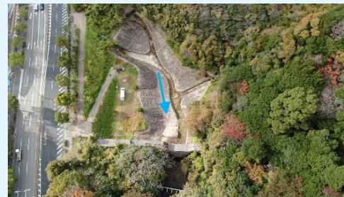
▲ 青山堰堤 (下流側から)
