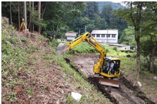
MC掘削状況
