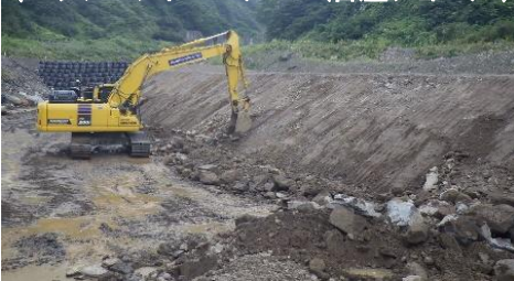
③ 掘削工 (マシンコントロールICT油圧ショベル)
