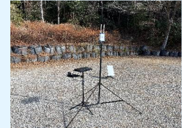
▲通信機器 設置状況
