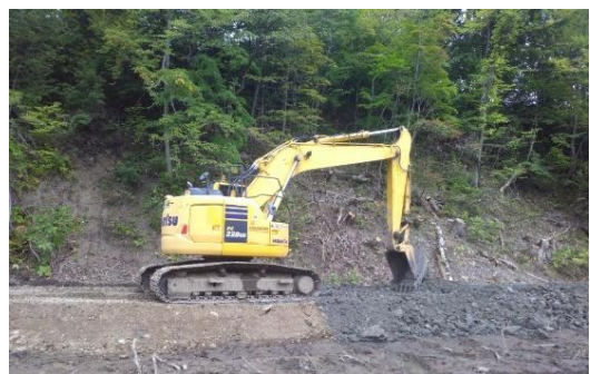
写真1 ICT機械作業状況
