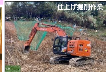
ICT建設機械による施工（マシンガイダンス）
