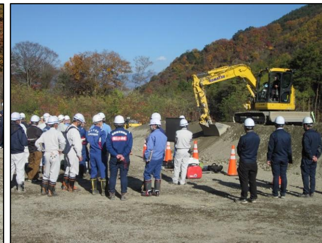
【ICT法面整形工を見学する参加者】
