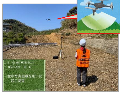
①. UAVによる起工測量
