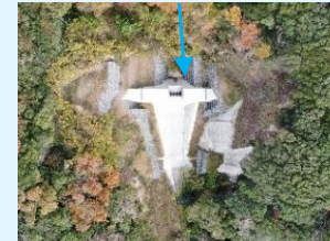
▲ 青山第四堰堤 (アングル2)
