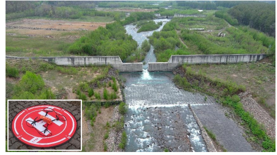
【大規模な砂防堰堤】
