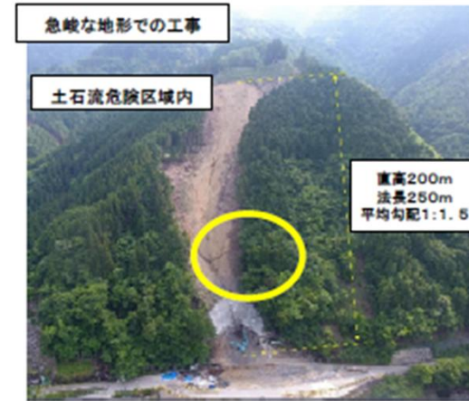
工事現場全景
