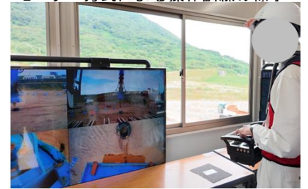
モニター方式による操作訓練の様子 (根固めブロック把持装置の操作)
