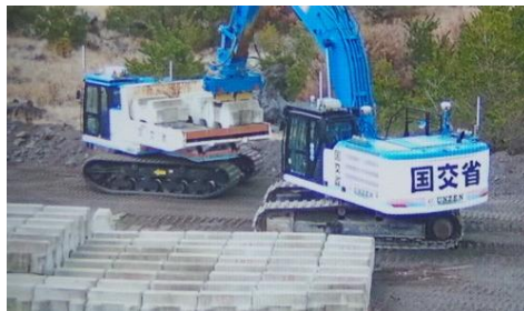
根固めブロック設置状況
