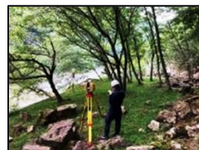
起工測量状況
