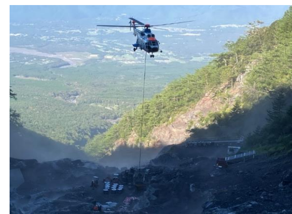
ヘリコプターでのコンクリート打設
