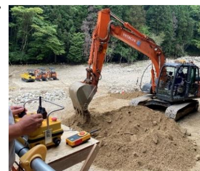
ロボQSによる無人化施工状況
