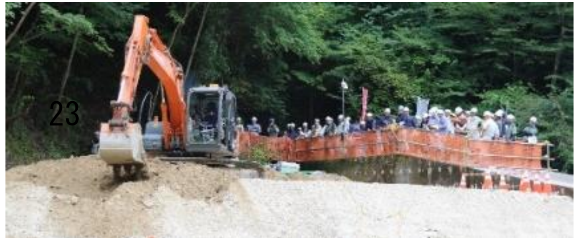
無人化施工の操縦体験会実施状況
