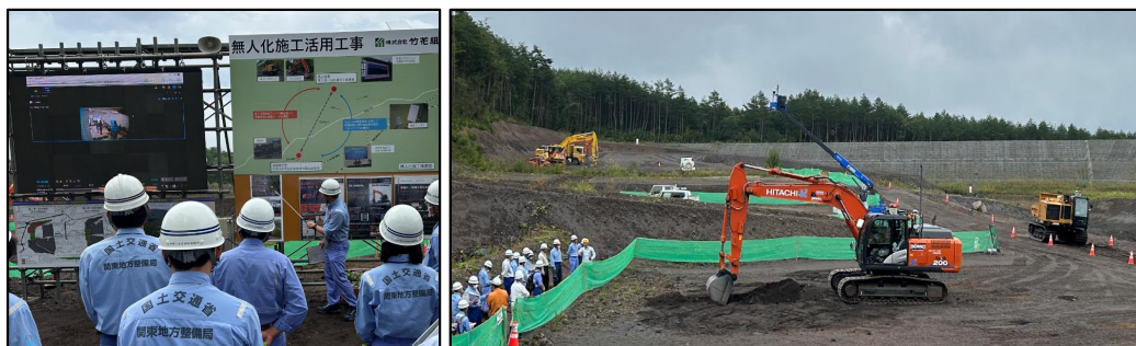
無人化施工機械(左:バックホウ、右:キャリアダンプ)
