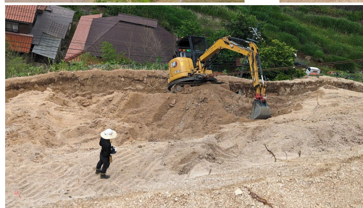
リモコン操作による掘削
