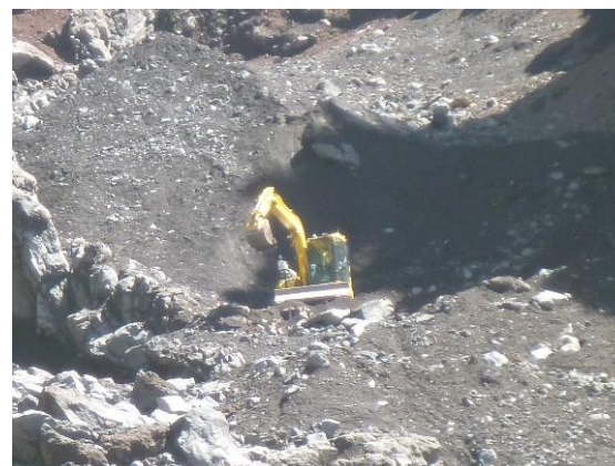
遠隔操作による掘削工
