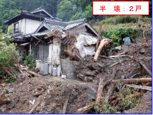
6/2 土石流 ありだぐんありだがわちようにさわ 和歌山県有田郡有田川町二澤
