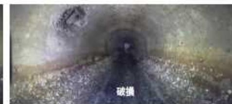
木根のほか破損や継手ズレ・浸入水等、多数の異常がKPROカメラによって確認された。この様にKPROカメラを用いることで、手軽に管内の概況を把握することが可能となるため、管口カメラ実施箇所以外のエリアにおいては、このKPROカメラを用いて管内点検を実施することを今後JVとして提案予定である。
