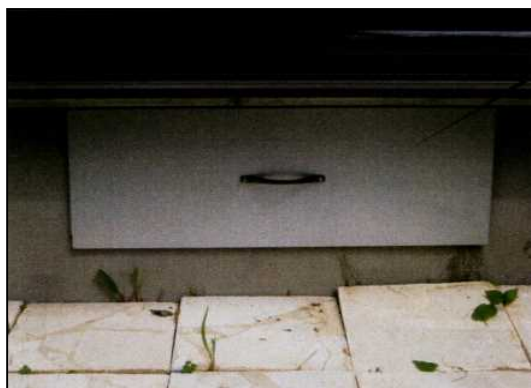
家屋のコンクリート基礎の 換気口からの流入 を防ぐ
