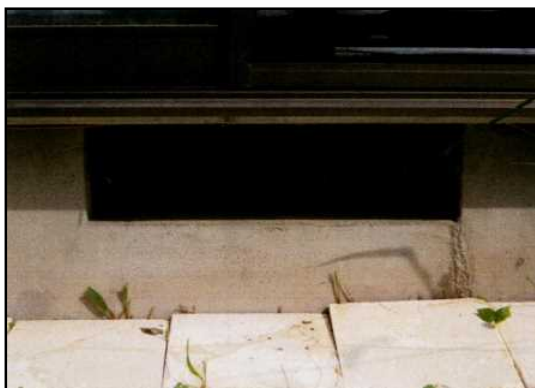
家屋のコンクリート基礎の 換気口からの流入 を防ぐ
