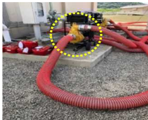
仮設ポンプ等の資機材の確保 (広島県倉敷市)
