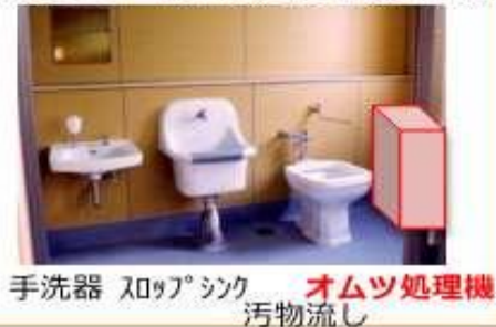
図2.汚物処理室へのオムツ処理機設置例
