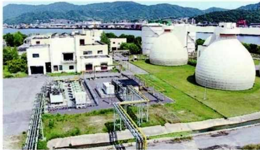
下水汚泥を集めて消化ガスを発生させるタンク⑥ （広島市南区）
