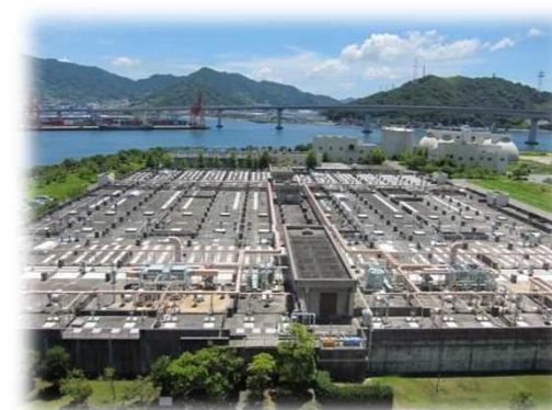
太田川流域下水道東部浄化センター
