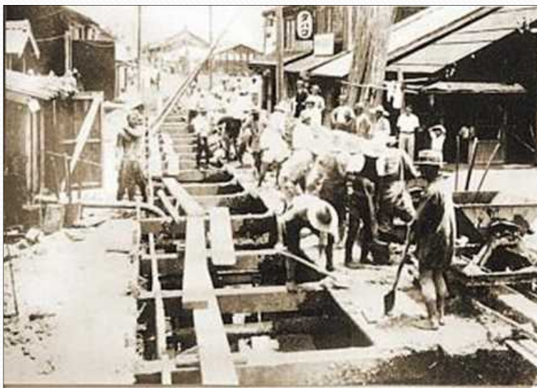
(昭和8年 船町幹線工事の様子)
