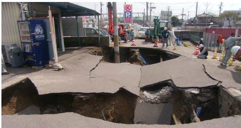
下水管から下水が漏れ 道路の下の土が減っていき、道路陥没
