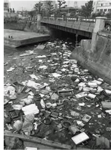
昭和45年(1970)野川【世田谷区】 ※多摩川クラブHPより
