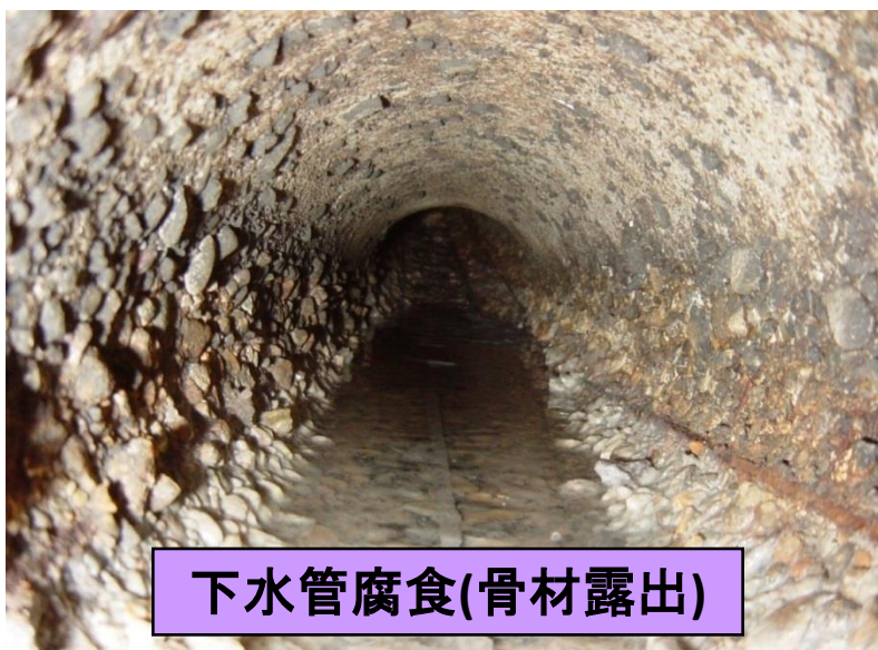
下水管から下水が漏れ 道路の下の土が減っていき、道路陥没
