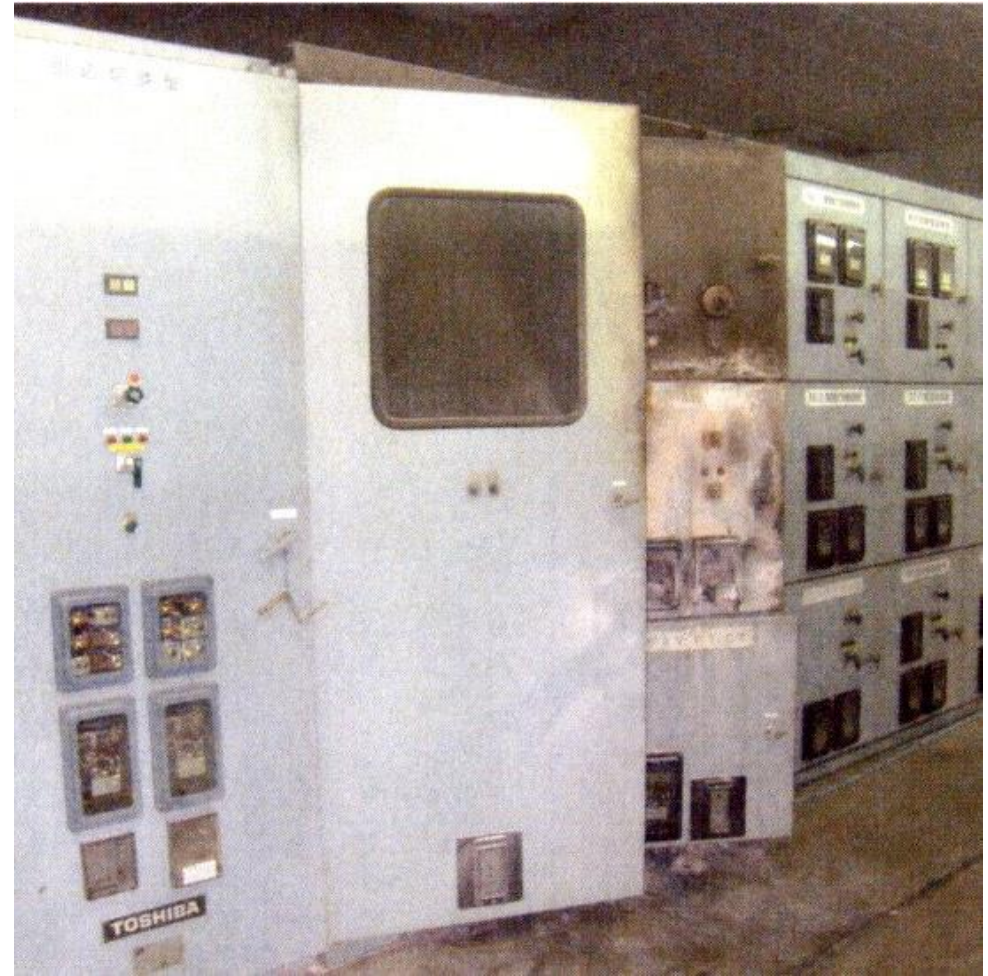
設備劣化で電気室火災発生 ⇒ 処理場機能の一時停止 放流先魚類の斃死 マンホールから汚水溢れ
