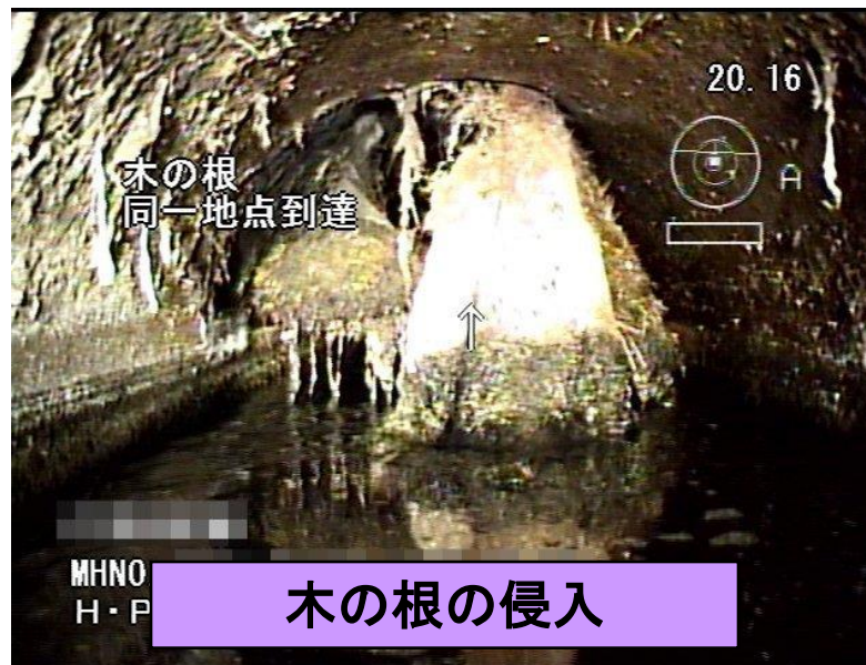
汚水溢れ の可能性
