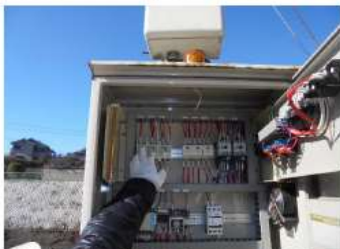
⑧制御盤内のポンプ切り替えスイッチを手動に、マンホール内の汚水を排水
