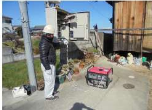
④制御盤内の電源プラグと延長コードを接続する
