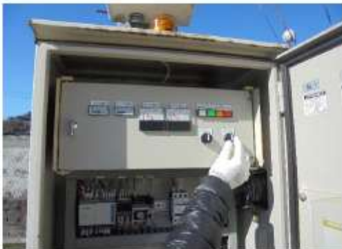
②制御盤内のポンプ切替スイッチを切にする
