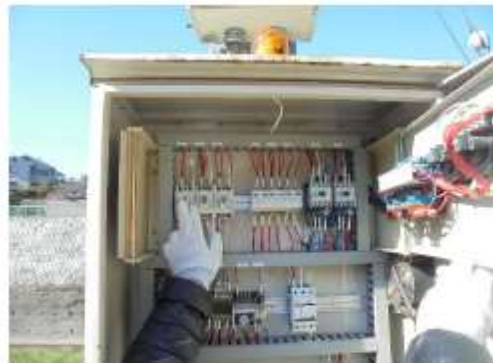
④制御盤内の電源プラグと延長コードを接続する
