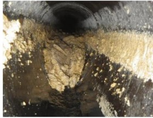
ラード(油)で閉塞した下水道管きよ
