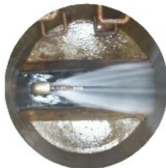
噴射ノズル・高圧水通水状況
