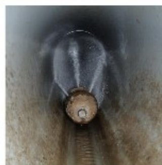
噴射ノズル・管内洗浄状況
