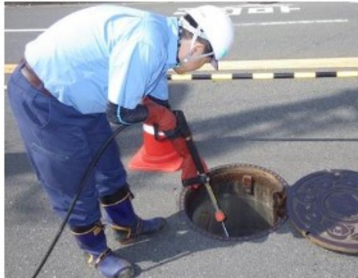
高圧水による洗浄状況
