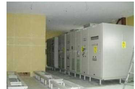
主要設備の嵩上げ
