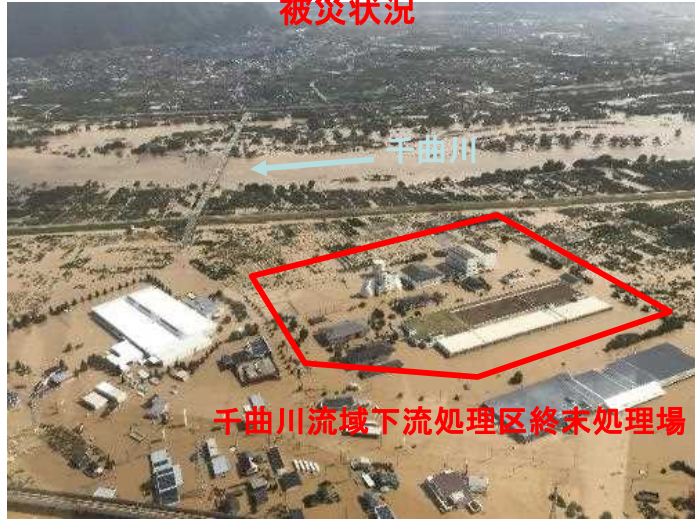
千曲川流域下流処理区終末処理場 (長野県 千曲川流域下流処理区終末処理場)
