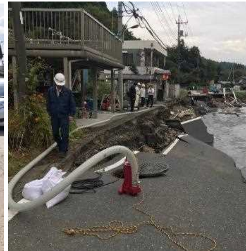
仮設ポンプ・仮設配管により汚水を圧送 (東京都日の出町)
