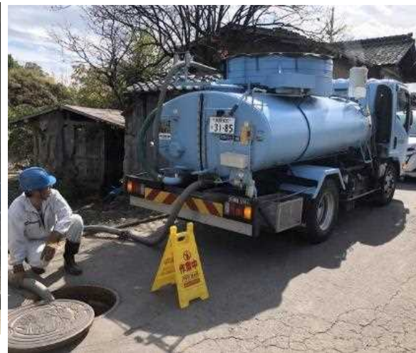
バキューム車により汚水を運搬 (長野県佐久市)
