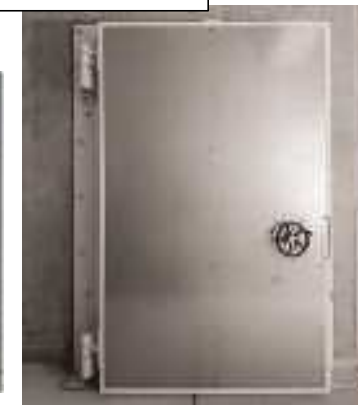
防水扉の設置
