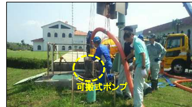
日本下水道管路管理業協会による 可搬式ポンプ、発電機の設置
