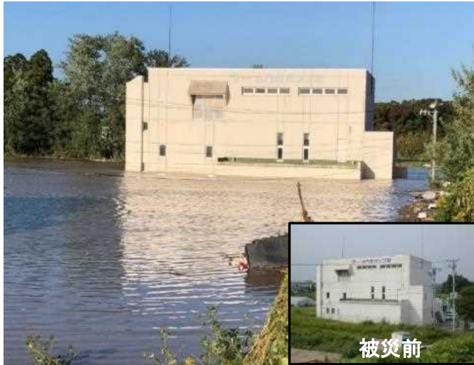
被災前 浸水したポンプ場 (福島県郡山市 水門町ポンプ場)
