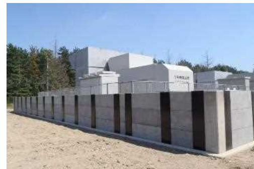
防水壁の設置
