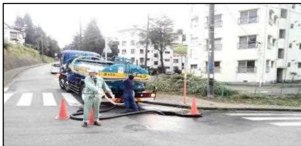
バキューム車による汚水の移送 (有秋台第1マンホールポンプ場)
