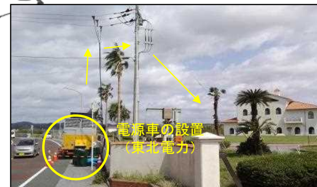
電力会社の電源車による受電
