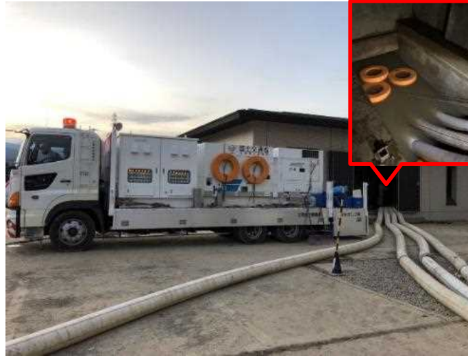
国交省の排水ポンプ車により施設内を排水 (長野県 千曲川流域下流処理区終末処理場)
