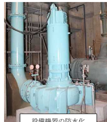
設備機器の防水化 (耐水型モーター)
