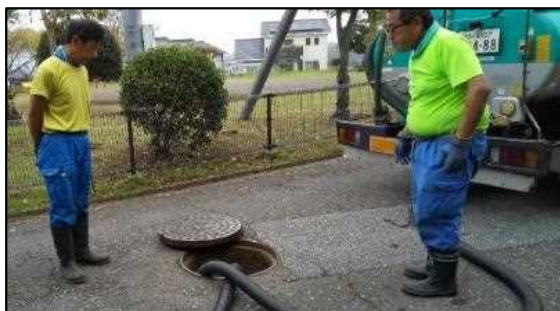
バキューム車による汚水の移送
