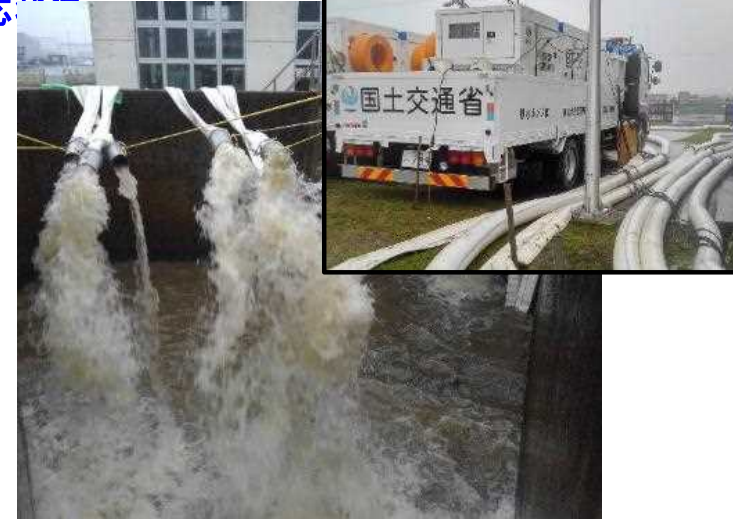
国交省の排水ポンプ車により雨水を排水 (仙台市 蒲生雨水ポンプ場)
