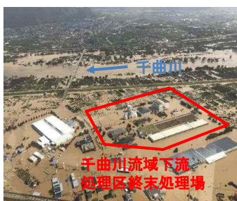
浸水した下水処理場 (長野県 千曲川下流処理区)
