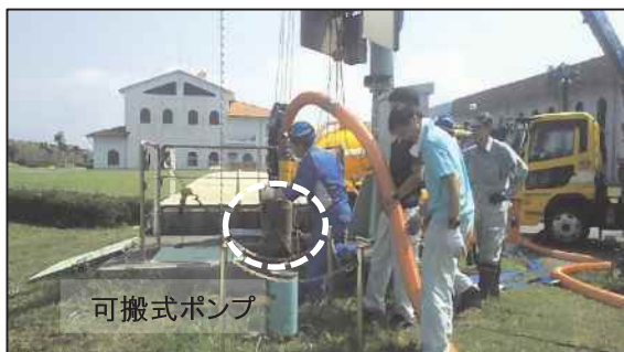
可搬式ポンプ、発電機の設置
