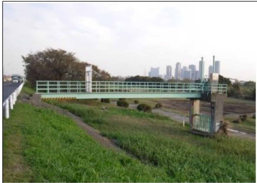
堤外側でゲート进行操作する樋門
