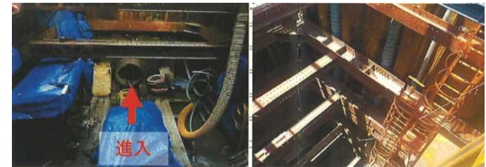
【状況写真】 発進立坑（中津町側）
