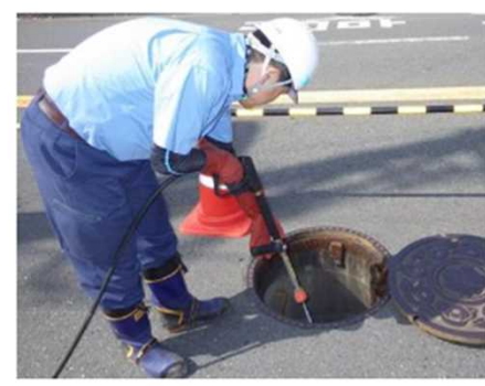
高圧水による洗浄状況
