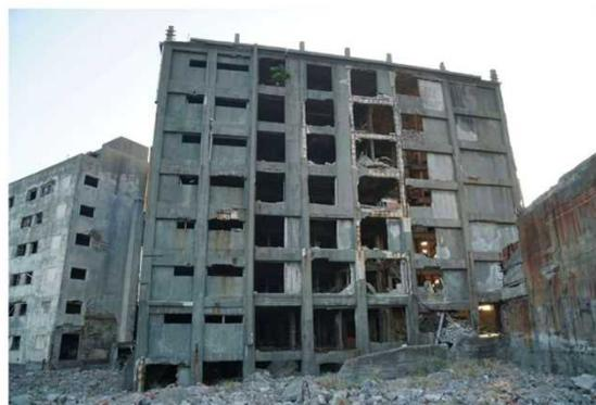
「軍艦島」を対象とした「構造物ヘルスマonitoringシステム」の実証運用にて、ワイヤレス振動センサにより、遠隔地からの構造物の常時モニタリングを実現
