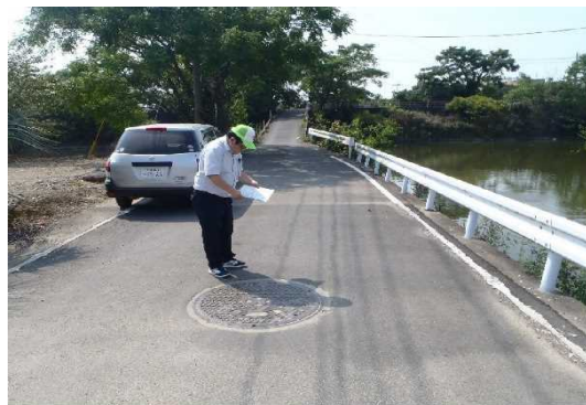
(13) 緊急点検状況(管渠・MH)
