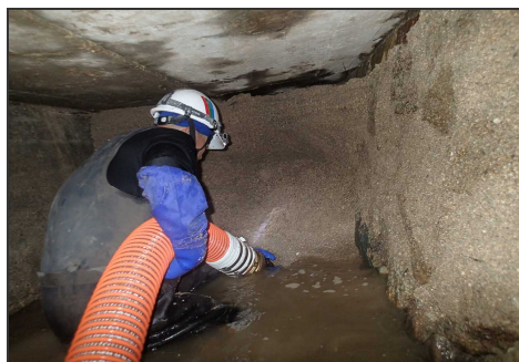
管路内土砂除去状況（広島市）
