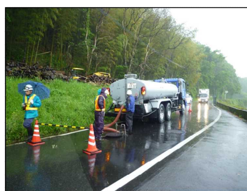
流域下水道マンホールへし尿投入
