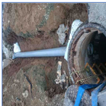
別幹線MHへ仮設管を布設
