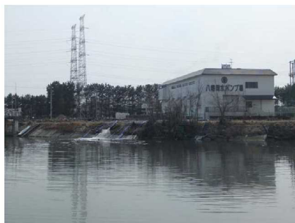
仮設ポンプによる排水
