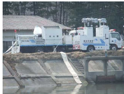
移動ポンプ車による排水
