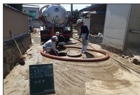
管路内土砂除去状況（広島市）
