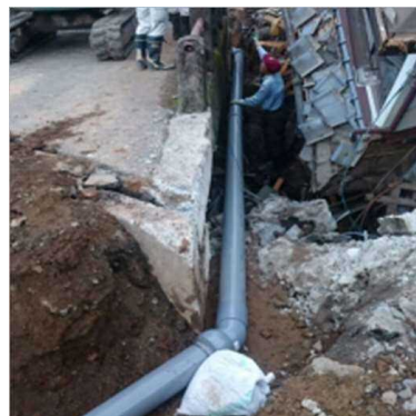
橋に仮配管懸架（露出）
