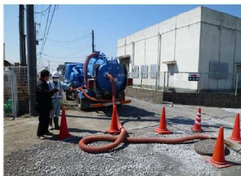
汚泥吸引車による吸引状況
