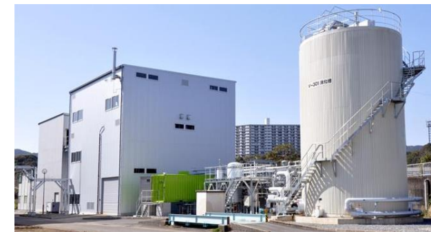
実証施設外観
