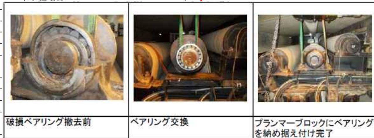
破損ベアリング撤去前
