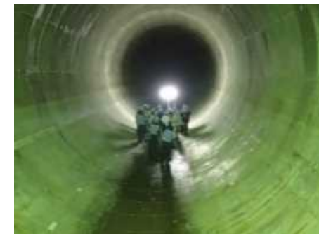
雨水貯留管の整備
