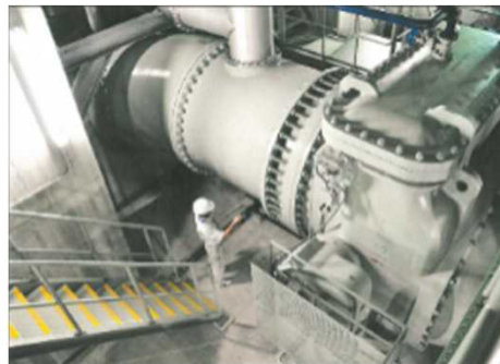
雨水ポンプの整備
