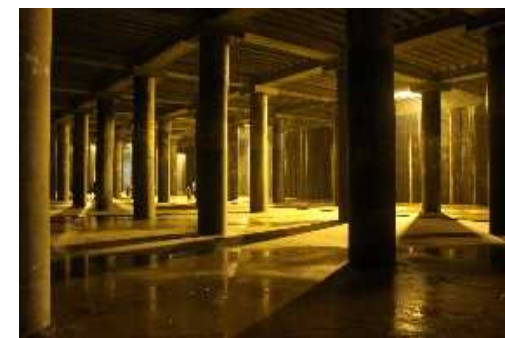
貯留施設の整備
