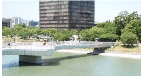
下水道普及後（平成27年）
