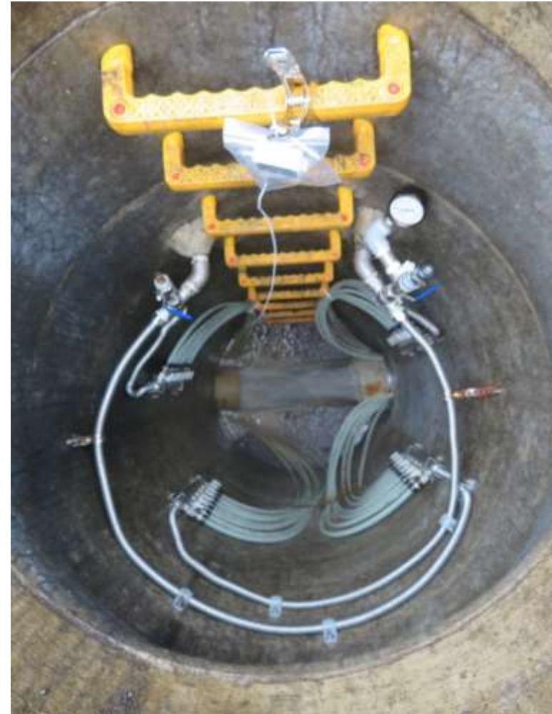
写真 7 計測器取り付け状況
