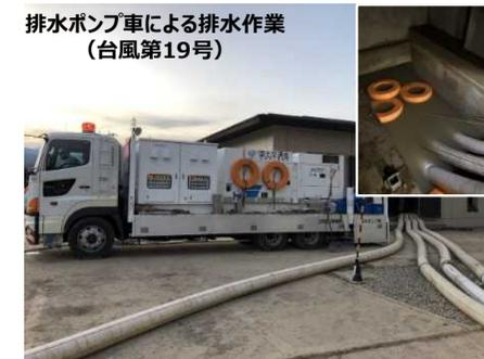
流入部が地下約25mと深いことから、排水及び揚水能力の確保に7日間を要した。(長野県千曲川流域下流処理区終末処理場)
