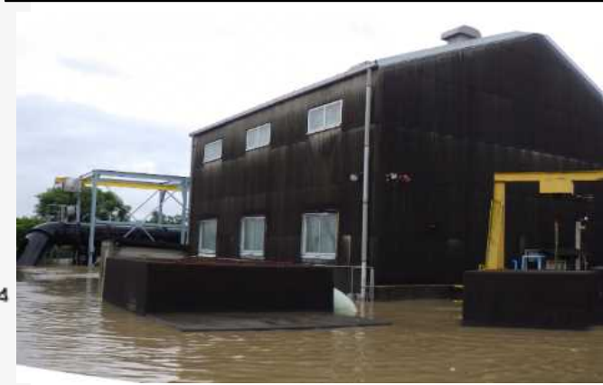
浸水した雨水ポンプ場
