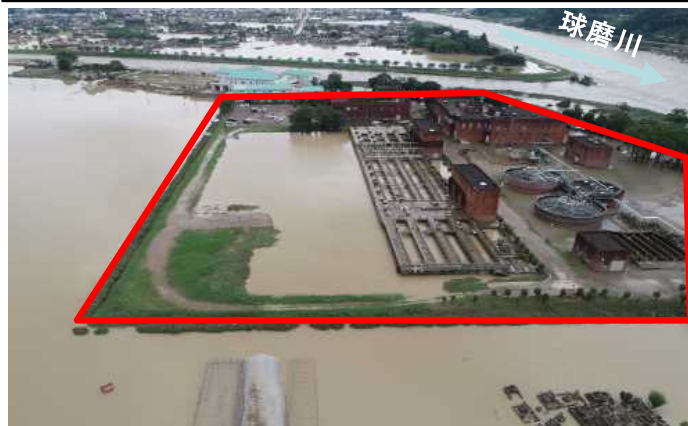
浸水した下水処理場
