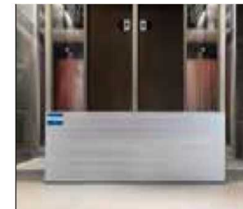
建物内への浸水防止策 (左：耐水扉 右：止水板)
