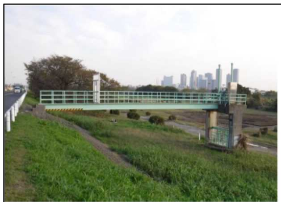
堤外側でゲート进行操作する樋門
