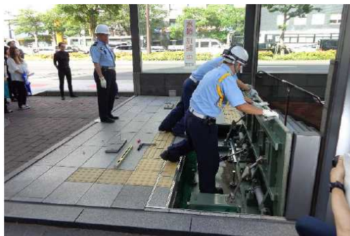
手動起上式止水板設置
