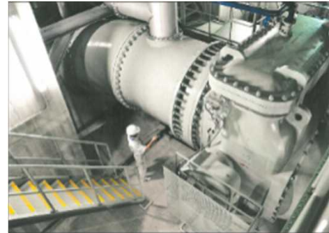
雨水ポンプの整備
