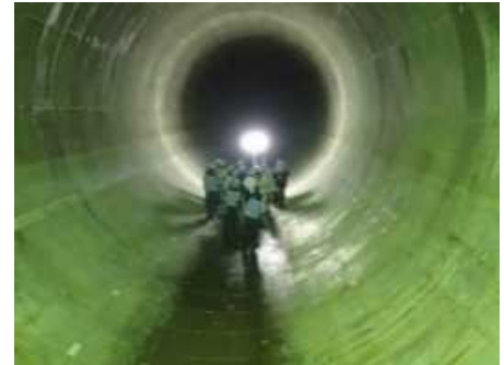
雨水貯留管の整備
