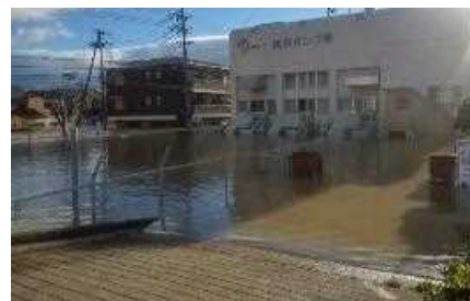
ポンプ場浸水状況
