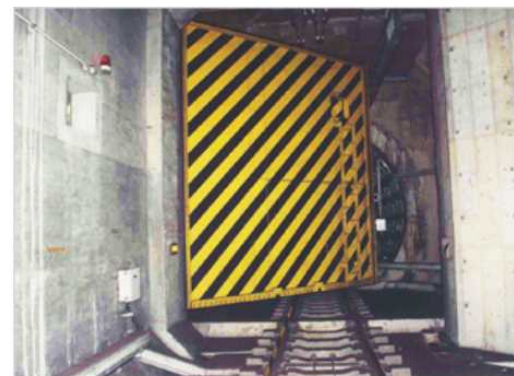
トンネル内防水ゲート
