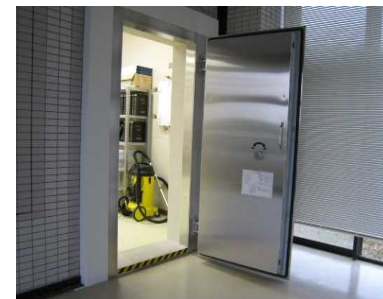
建物内への浸水防止策 (左：耐水扉 右：止水板)
