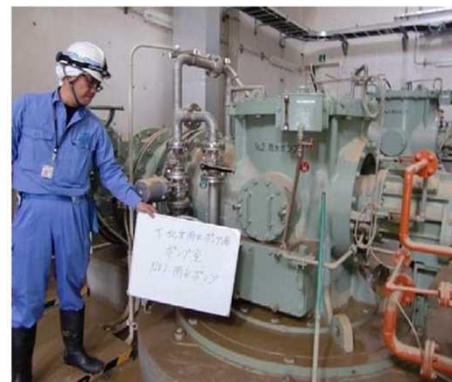
浸水した雨水ポンプ
