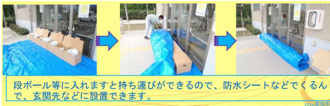
簡易「水のう」の設置例
