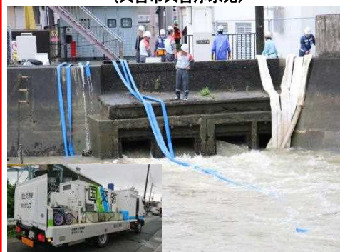
排水ポンプ車により雨水を排水 (大牟田市三川ポンプ場)
