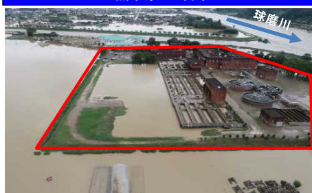
浸水した下水処理場
