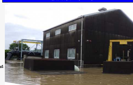
浸水した雨水ポンプ場
