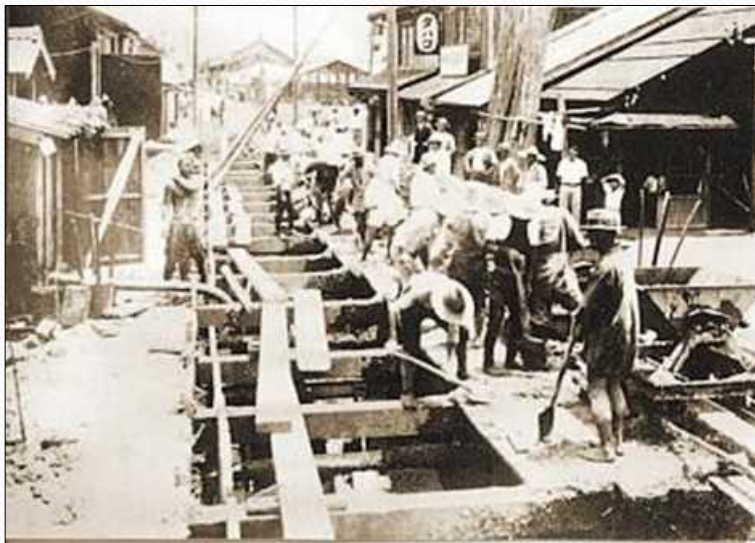
(昭和8年 船町幹線工事の様子)
