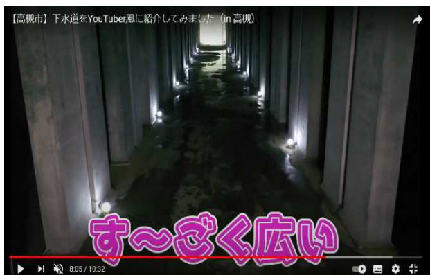
非日常の世界を体験できる空間 (雨水貯留施設内部 20,000m 3 )
