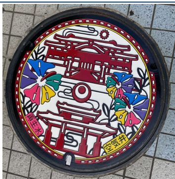
実際に設置されたマンホール蓋
