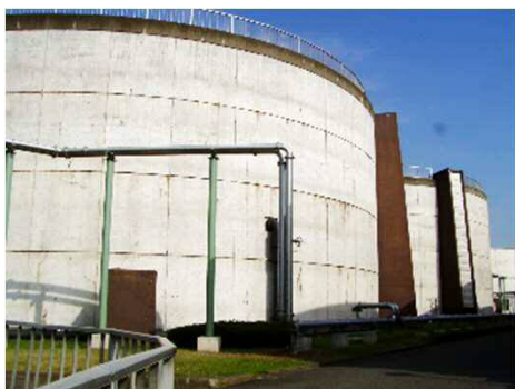
汚泥消化ガス発電（消化槽・発電機）
