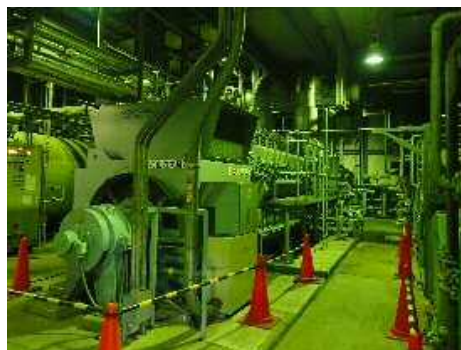
汚泥消化ガス発電（消化槽・発電機）
