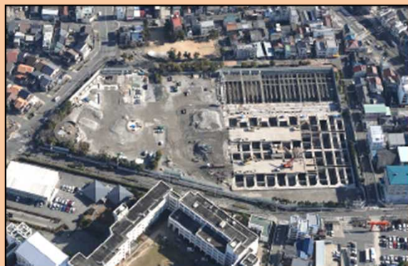
撤去工事が進む中部処理場（平成24年）
