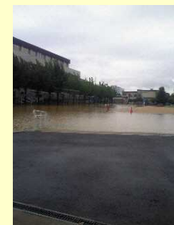
校庭貯留施設（雨天時）
