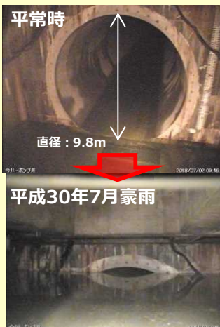
南部地下河川
