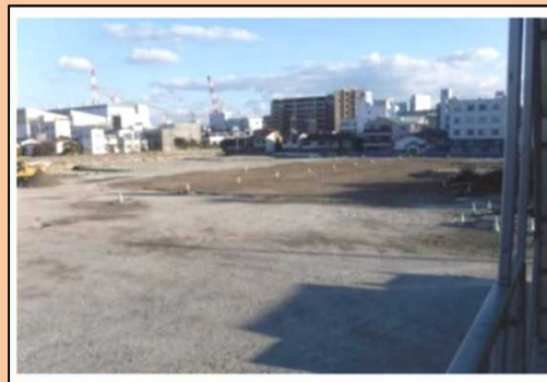
地上部施設の撤去が終わり整地された跡地
