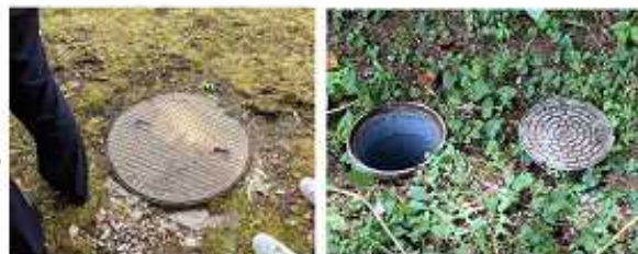
▲ 施設内に設置されたますの例
