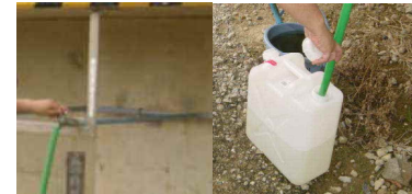
市民への配布（給水施設の設置）
