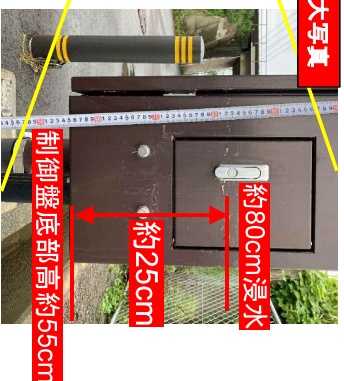
制御盤を上げた後
