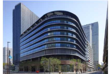
図5 銭瓶町ビルディング外観 (R4.3竣工、ポンプ所及び庁舎併設)
