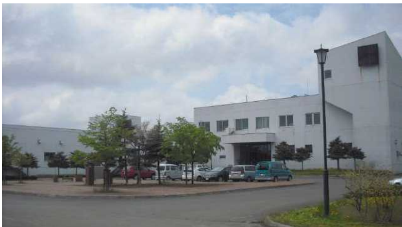
南光園処理場管理棟・水処理棟
