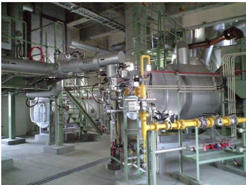
汚泥乾燥機（南光園処理場乾燥機棟）
