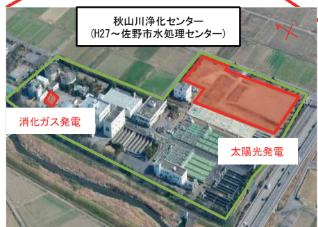
秋山川浄化センター 発電設備(ガスエンジン5台) 太陽光発電(940kW)
