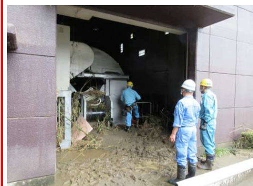
日本下水道事業団による現地調査(熊本県人吉市)
