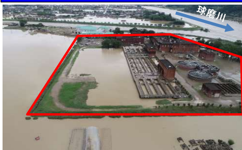
浸水した下水処理場
