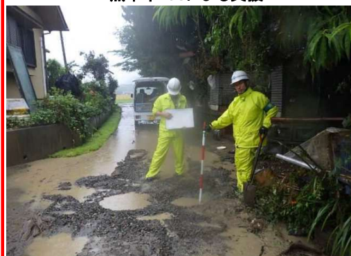
熊本市による管路調査(熊本県人吉市)
