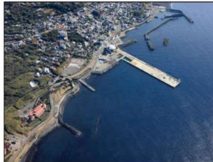
噴火避難用岸壁の整備
