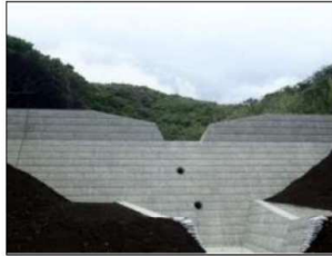
砂防堰堤の整備
