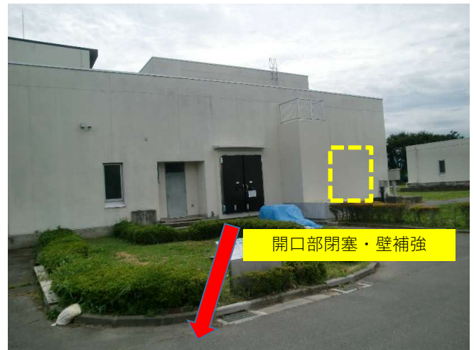
放流ポンプ棟耐水化
