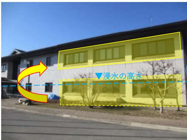
管理棟電気室（1階から2階へ移設）
